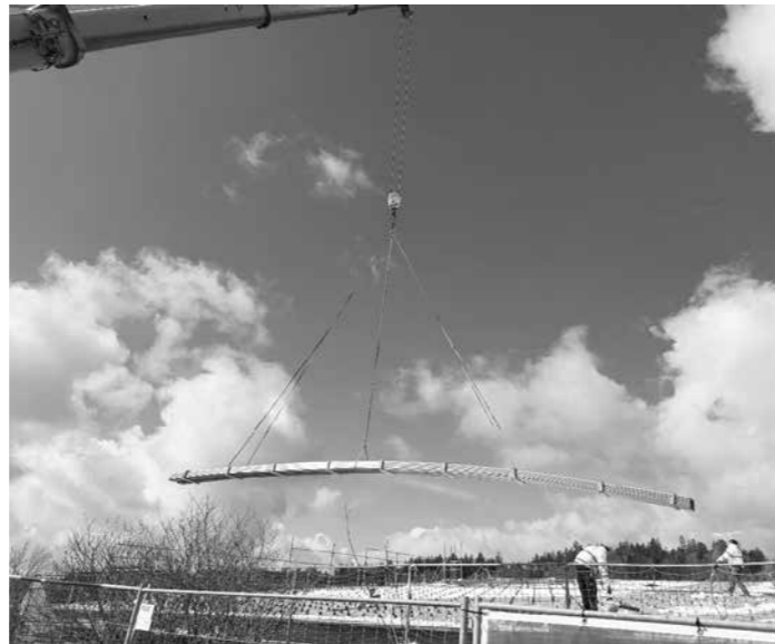
28.03.2023 – und am nächsten Tag abgeladen und montiert. Da es in der Nacht geschneit hatte, mussten am morgen erstmal gut 5 cm Schnee vom Dach geräumt werden.
