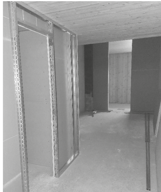
26.02.2023 – ein Blick in die Umkleieräume im OG
