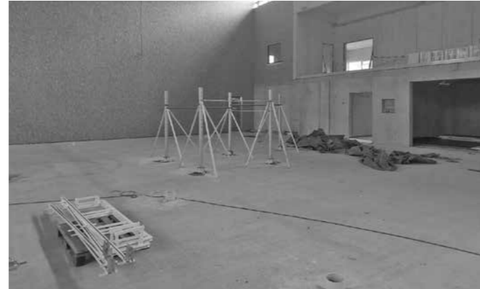
13.04.2023 – Einbau der Bodenhülsen für die Sportgeräte
