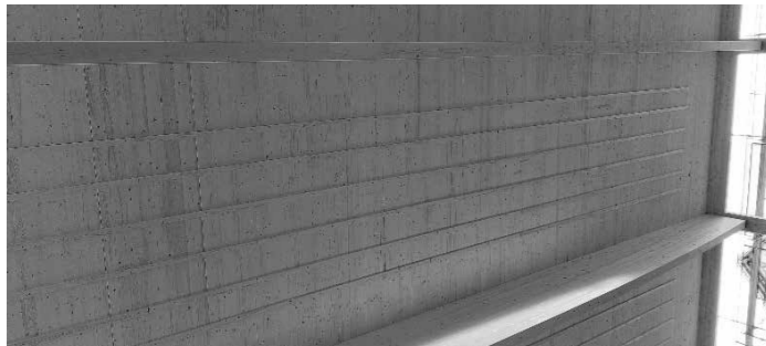
16.03.2023 – Einbau der Unterkonstruktion für die Akustikdecke.
