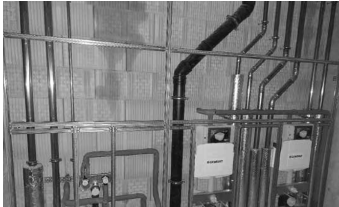
10.03.2023 – viele Rohre sind notwendig für die Heizung und die Sanitäreinrichtungen.
