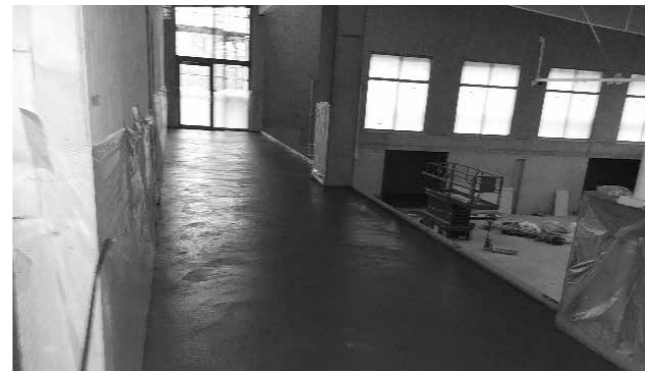
21.04.2023 – der Estrich im Obergeschoss ist schon drin
